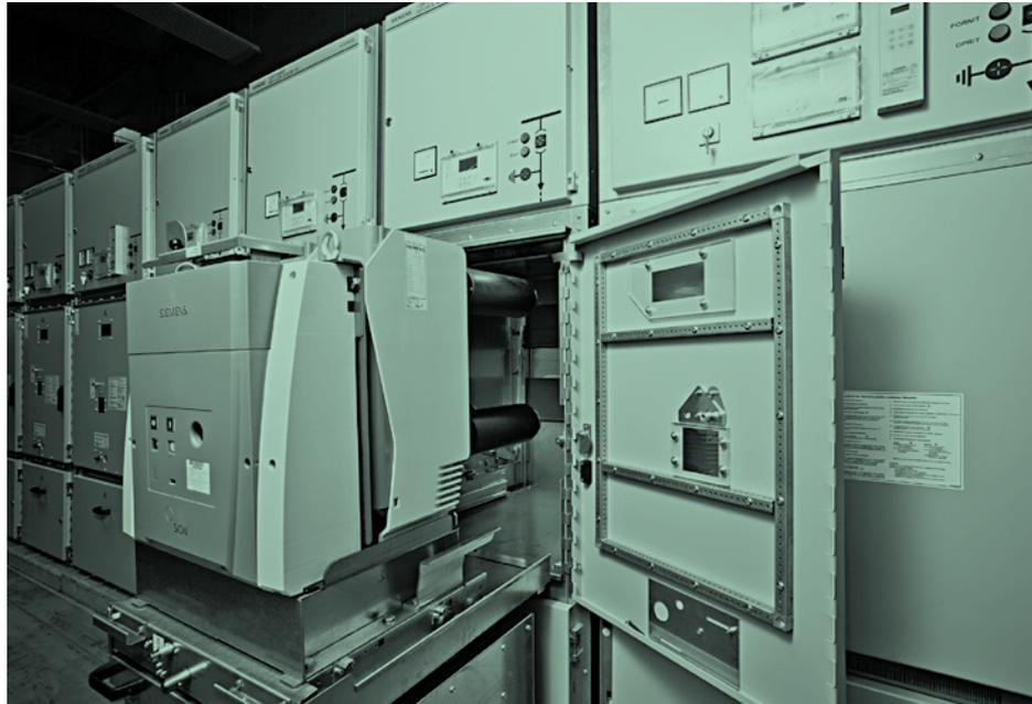
**Leistungsschalter in Einfahrstellung**
